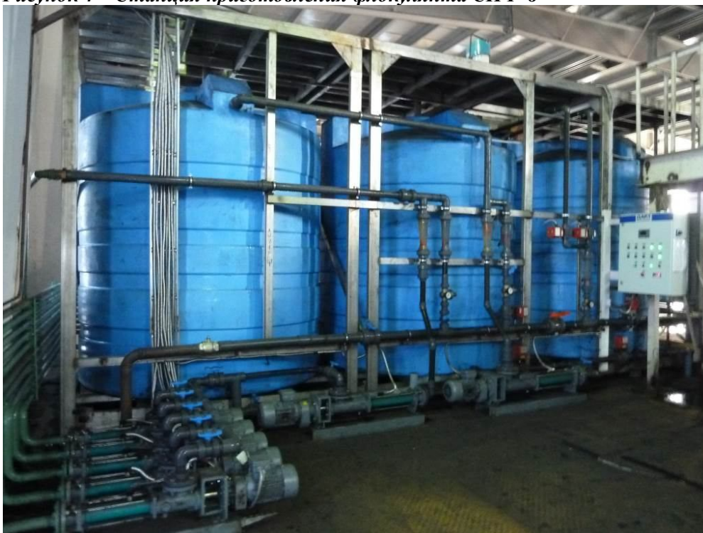
Рисунок 4 – Станция приготовления флокулянта СПФ-8
