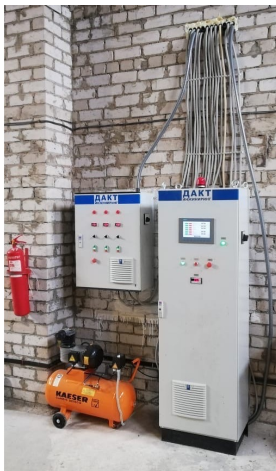
Фото шкафа управления комплексом
